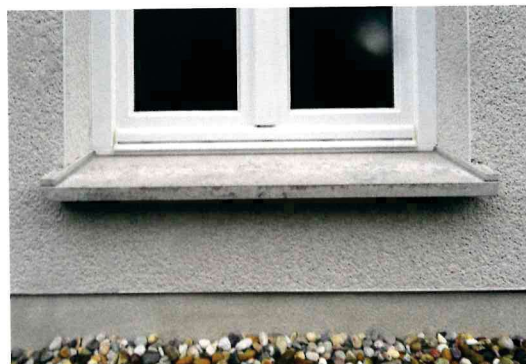
Abb. 46a: Steinfensterbank mit seitlicher Aufkantung aus Steinstreifen
